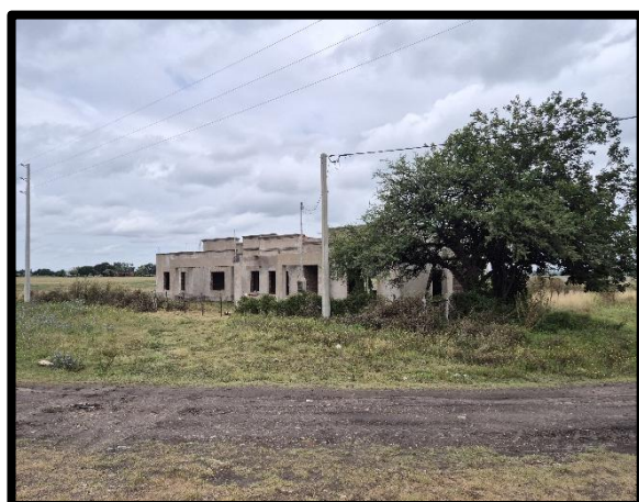
Figura 69 – Vivienda en construcción, intersección RPNº26 y traza.
