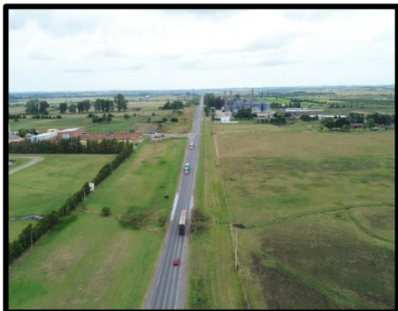
Figura 71 – Vista aérea RPNº26 hacia el sudoeste.
