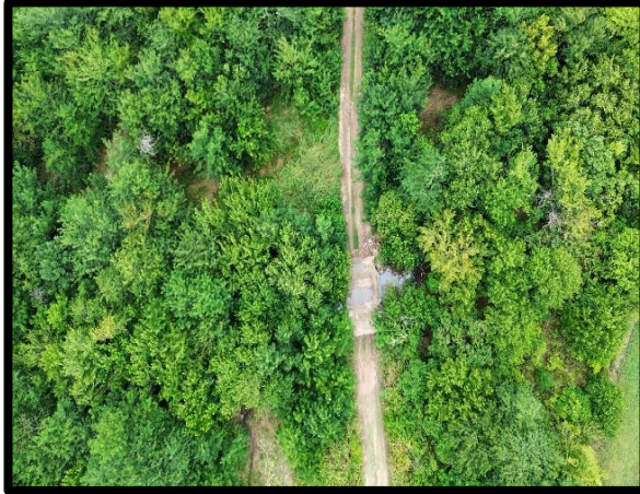
Figura 91 – Vista aérea punto donde se construirá puente sobre arroyo Chañar.
