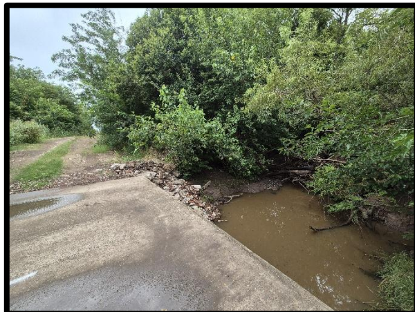
Figura 94 – Puente sobre arroyo Chañar.
