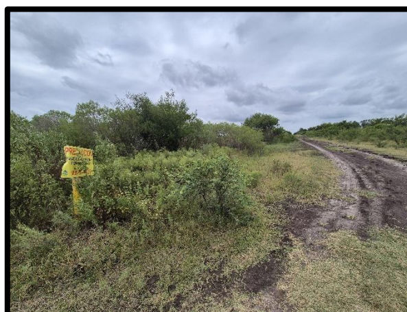
Figura 82 – Vista traza e intersección calle pública, se observa presencia de gasoducto.
