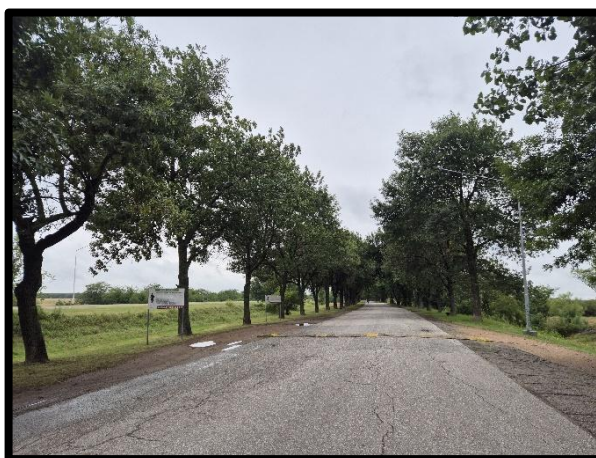
Figura 43 – Paseo de los Puentes “Beto García”.
