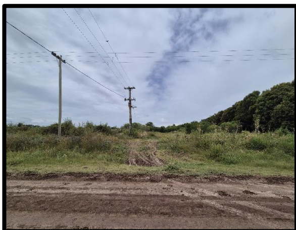
Figura 85 – Traza desde predios privados e intersección con calle pública, vista hacia el sudeste.
