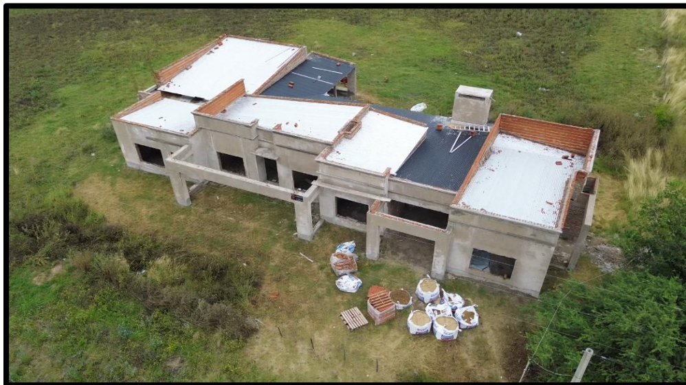
Figura 61 – Vivienda en construcción (activa).
