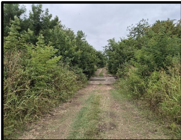
Figura 93 – Puente sobre arroyo Chañar.
