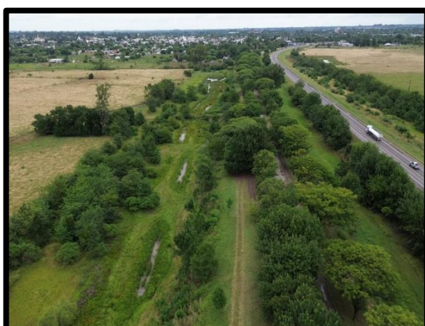
Figura 51 – Vista aérea del Paseo de los Puentes ‘Beto García’, lado oeste.
